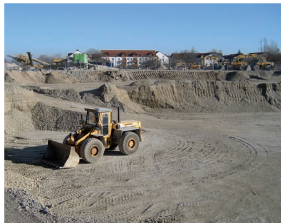
Bild 11: Unsere Baustelle in der Altlaufstraße/Höhenkirchen-Siegersbrunn
