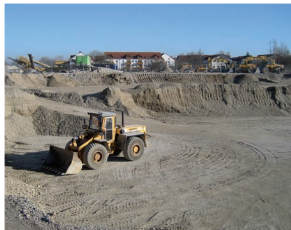
Bild 11: Unsere Baustelle in der Altlaufstraße/Höhenkirchen-Siegertsbrunn
