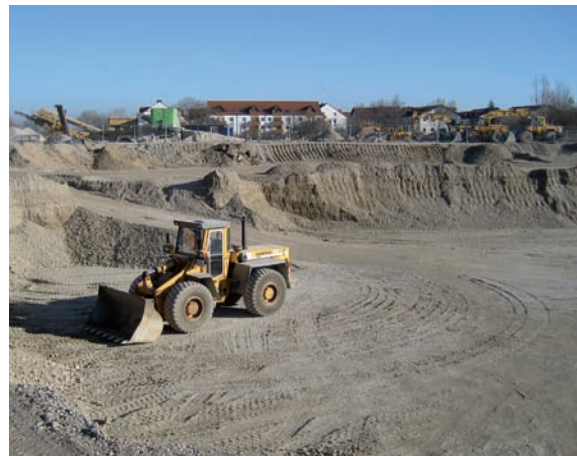
Bild 11: Unsere Baustelle in der Altlaufstraße/Höhenkirchen-Siegertsbrunn
